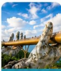
สะพานมือสีทอง
