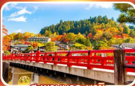
สะพานนากะบาชิ
